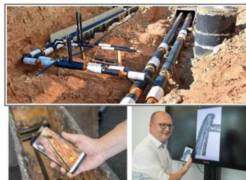
Abbildung 21: Datenerfassung mittels einem handelsüblichen Mobiltelefons (Fraunhofer IPM, 2020)
